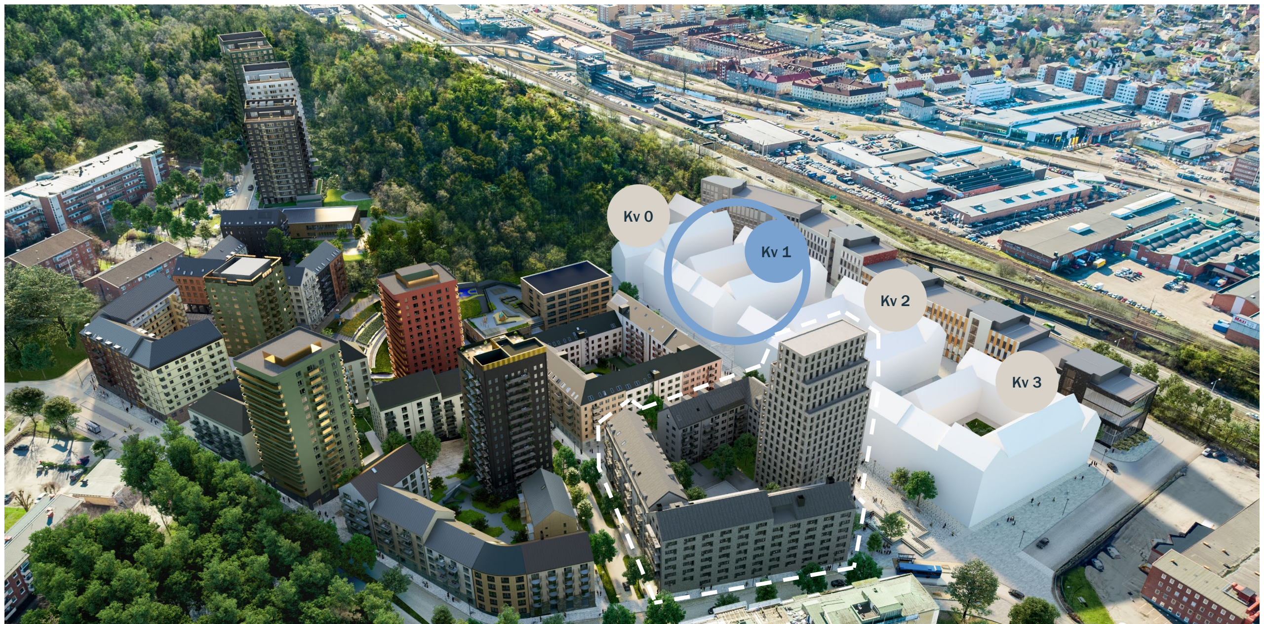
Kallebäck's Terrasser, Göteborg – 2 000 lägenheter (cirka 500 kvar att byggstarta)
